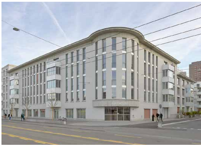
Ecksituation an der Hohlstrasse mit Eingang zum Zürcher Lighthouse
